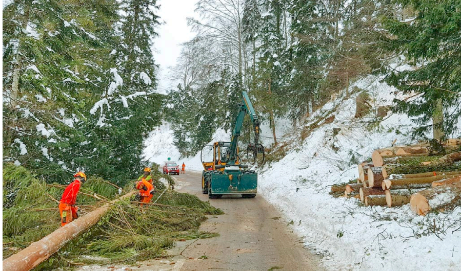
Holzschlag im Goldachtobel ▶
