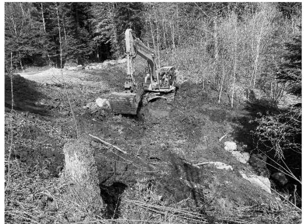
Durchlasssanierung Wattwald
