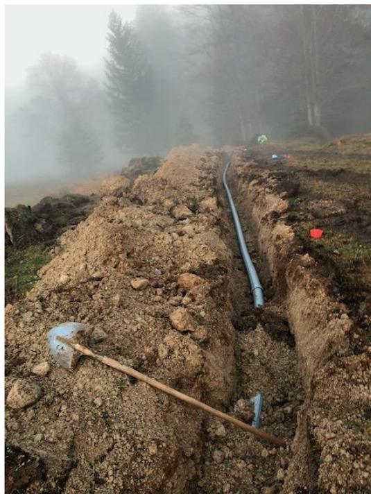
Bildlegende: Wasserleitungsgraben im Schwamm kurz vor dem Einfüllen
