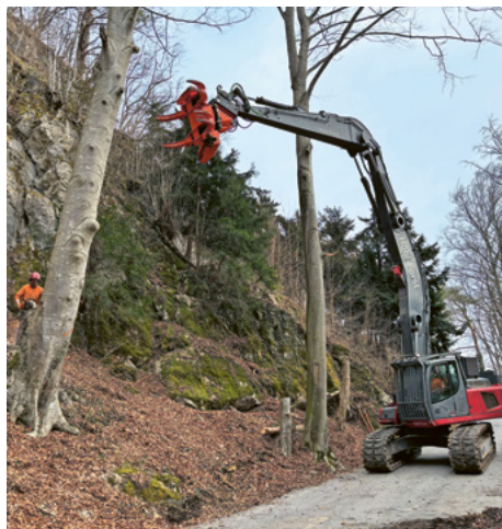
Spezialholzerei an der Freienbachstrasse im Bereich Freienbach – Stein.
