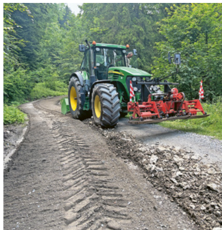
Felsmaterialeinbau mit mobilem Brecher
